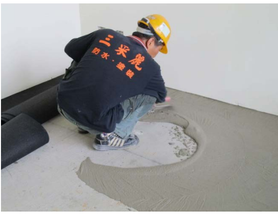
步驟五：將樹脂砂漿抹於打底完成之素地面
