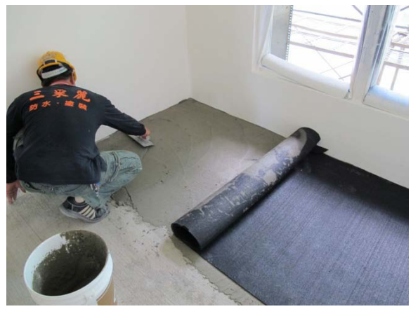
步驟六：於砂漿平後，立即將隔音材 SILENTSTEP RU 鋪設於砂漿表面
