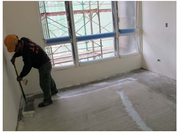
步驟二：全面將素地粉塵清潔乾淨後，再以黏結樹脂 稀釋三倍水進行打底
