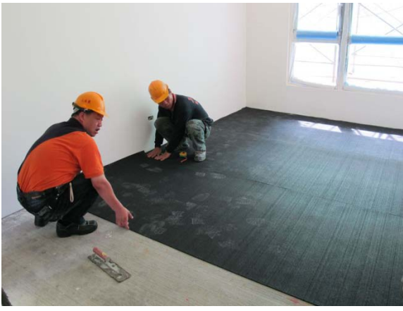
步驟三：現場進行隔音材 SILENTSTEP RU 裁切及預鋪
