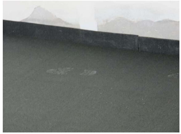
步驟八：轉角立面施作隔音材約5公分(踢腳板型)選配產品
