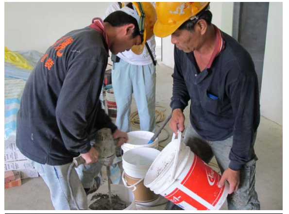
步驟四：將稀釋好的黏結樹脂 與水泥砂做拌合成為樹脂砂漿
