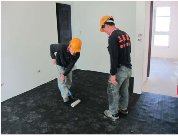
步驟七：將鋪設好的隔音材 SILENTSTEP RU 充分壓為平整
