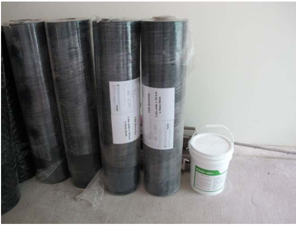
步驟一：現場進貨儲放(包含：隔音材 SILENTSTEP RU 與黏結樹脂)
