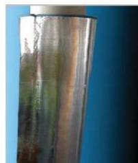
包覆固定後，在以鋁箔膠帶順著縱向長度做貼合
