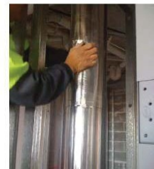
所有交疊處均須確實以鋁箔膠帶密封完整
